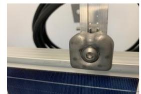
5. Die Aluwinkel (2 pro Schiene) mittels der mitgelieferten Befestigung in die Schiene schieben und festziehen.
