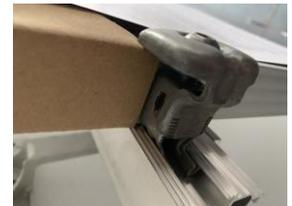
4. Die Befestigungsklemmen so justieren, dass diese am Modulrahmen aufliegt und mit einem Inbus festziehen.
